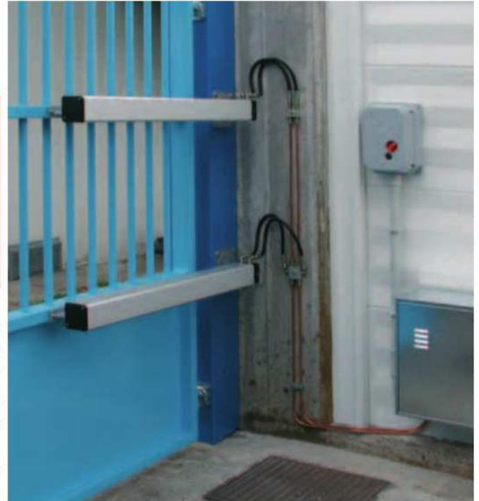
El MEC 800 es un automatismo oleodinámico eficaz para mover puertas, portones y ventanillos de superficie compacta de grandes dimensiones, hasta un peso de 800 Kg, sin ninguna limitación en el número de maniobras. Para los casos en los que se requieren prestaciones superiores, MEC 800 Special se puede instalar en la versión con dos pistones hidráulicos y una sola centralita en cada hoja.
