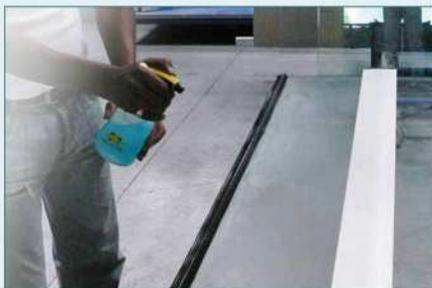
**3.3** Lubri car el exterior de la junta (parte superior y fondo) con el vaporizador.
