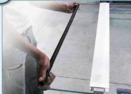
**3.1** Cortar la junta a larga del travesaño. Cortar todo recto siguiendo el labio de la junta únicamente en el caso de un acristalamiento de 10 mm.
