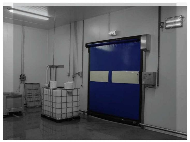
El sistema exclusivo y patentado de reparación automática de Rayflex tiene como un diferencial la ausencia total de piezas rígidas en sus lonas. En el caso de impacto con una apiladora ninguna parte de la lona sufre daños y vuelve a su funcionamiento normal automáticamente. Este sistema genera bajo mantenimiento, evita posibles cambios de piezas, elimina paradas de producción por falta del funcionamiento de la puerta y le asegura una larga vida útil al equipo.
