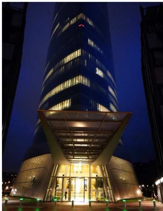
Pilonas instaladas en torre Iberdrola - Bilbao
