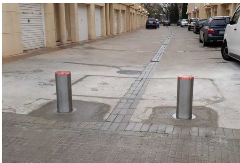
Pilonas instalas en comunidad de vecinos
